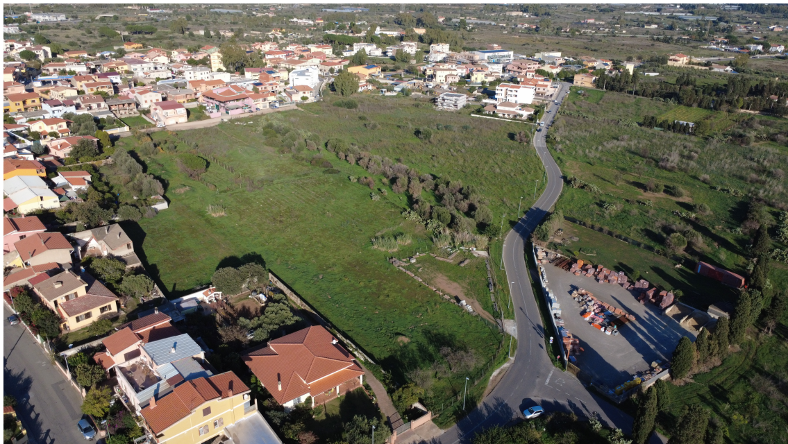
Foto 4_ ripresa aerea dell'area d'intervento ante
