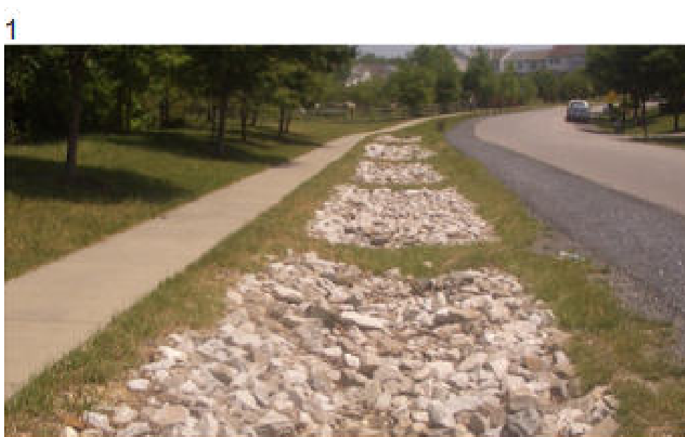
1 - Trincea di infiltrazione
