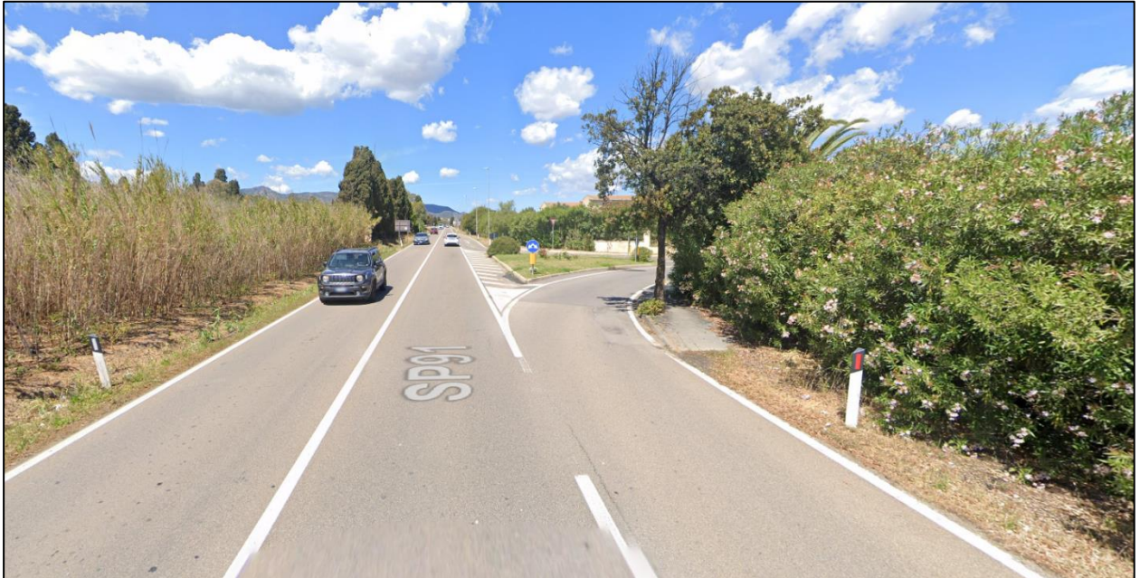
Figura 4 - Vista intersezione provenendo dalla SS 195 [Fonte: Google Street View]
